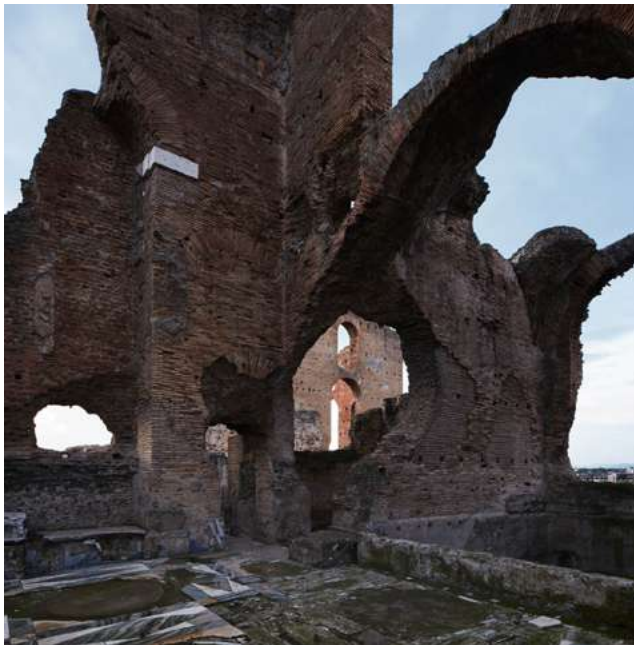
Fig. 1 The frigidarium of the Villa dei Quintili (Photo: L. Filetici 2018)
